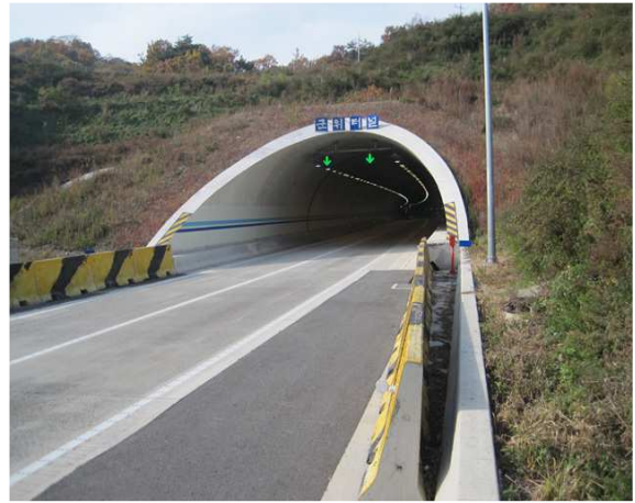
3공구 군위터널(상주방향) 종점부
