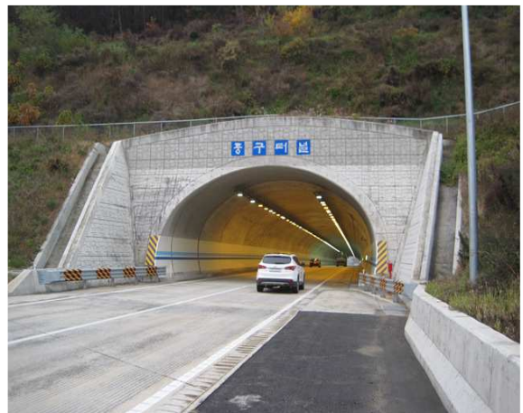
5공구 중구터널(상주방향) 종점부
