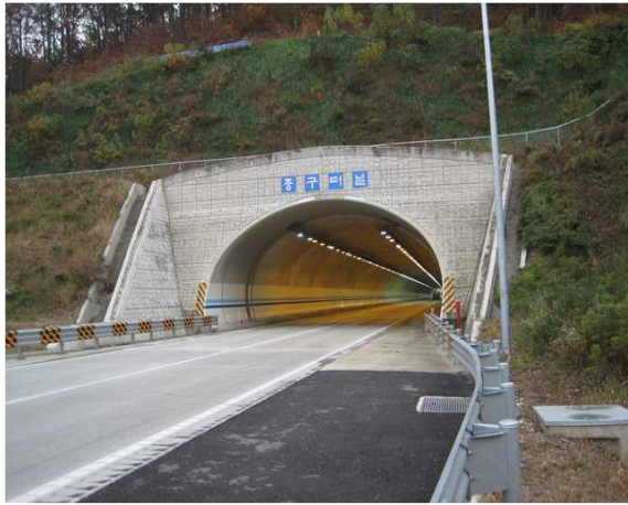
5공구 중구터널(영천방향) 시점부
