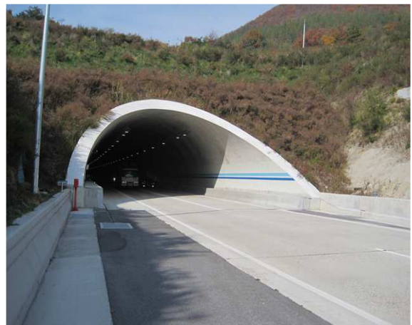
3공구 군위터널(영천방향) 종점부
