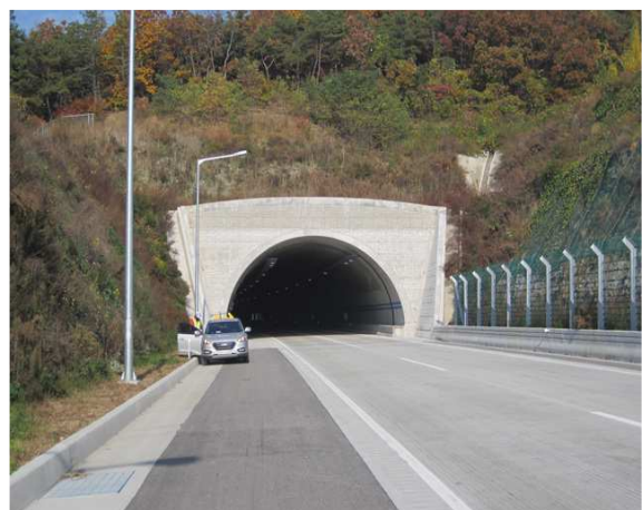
4공구 평호터널(영천방향) 종점부
