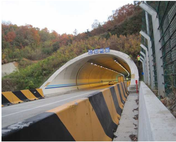
4공구 산법터널(영천방향) 시점부
