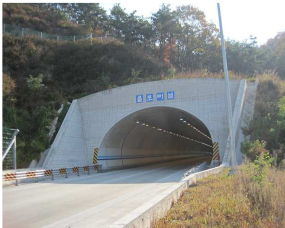
5공구 불로터널(영천방향) 시점부
