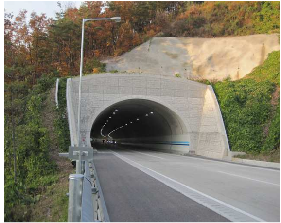
4공구 산법터널(영천방향) 종점부
