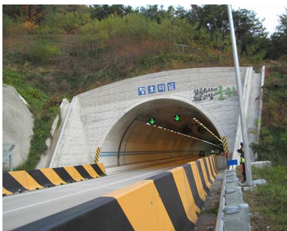
4공구 평호터널(영천방향) 시점부
