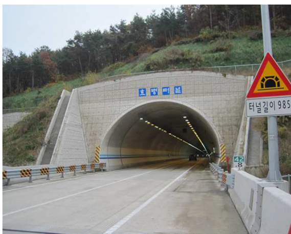
5공구 효령터널(영천방향) 시점부
