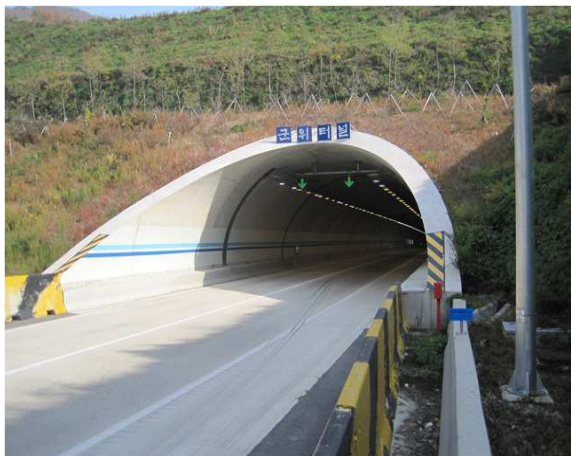
3공구 군위터널(영천방향) 시점부
