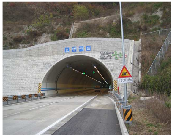
5공구 효령터널(상주방향) 종점부
