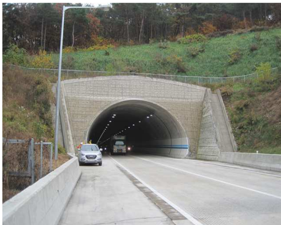
5공구 효령터널(상주방향) 시점부
