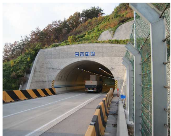
4공구 산법터널(상주방향) 종점부
