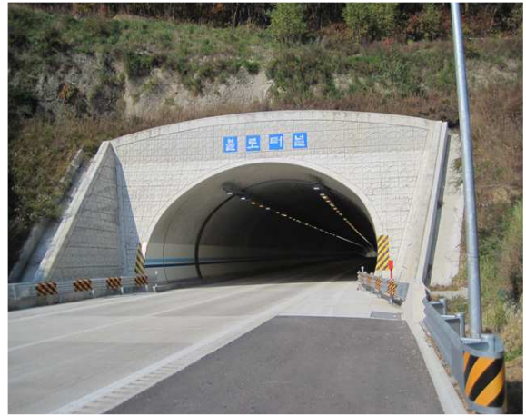
5공구 불로터널(상주방향) 종점부
