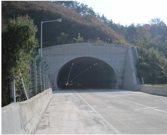
5공구 불로터널(상주방향) 시점부
