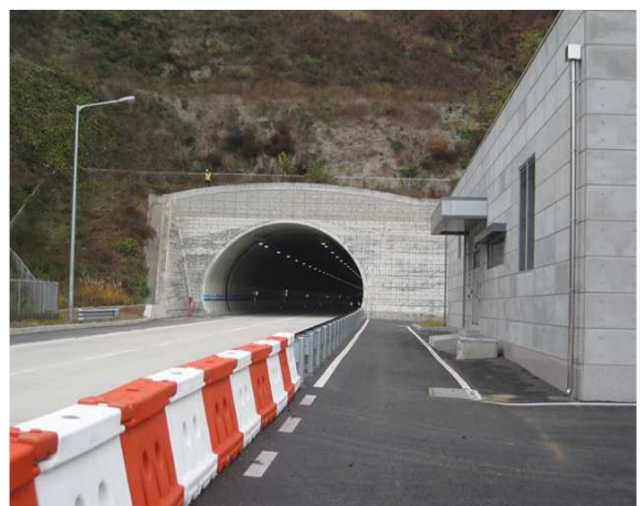
5공구 효령터널(영천방향) 종점부
