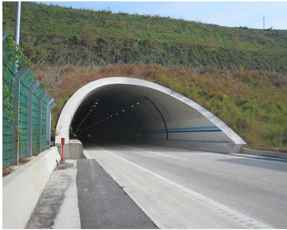
3공구 군위터널(상주방향) 시점부
