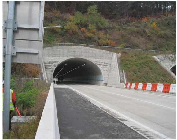
5공구 중구터널(영천방향) 종점부
