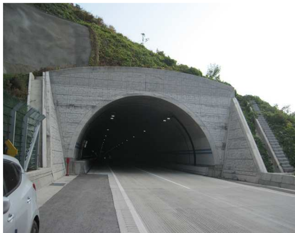
4공구 평호터널(상주방향) 시점부
