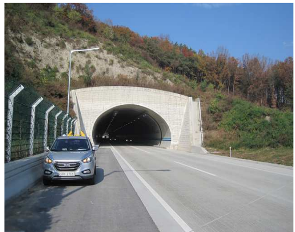
5공구 불로터널(영천방향) 종점부
