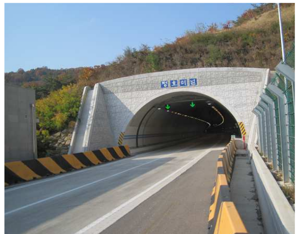
4공구 평호터널(상주방향) 종점부
