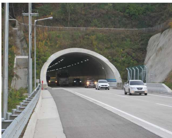
4공구 산법터널(상주방향) 시점부
